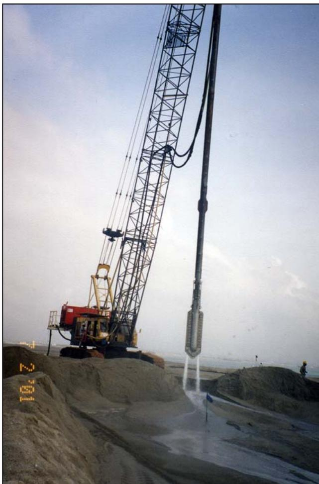
Грунтовые и песчаные массы, поступающие на поверхность в процессе работы вибропик, подаются к центру будущих колонн фронтальным погрузчиком 966F Caterpillar.
