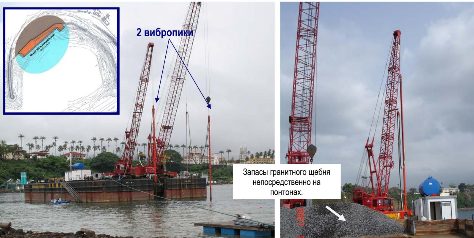
Вибропики установлены на 2 плавучих понтонах и смонтированы в свободном подвесе на гусеничных кранах грузоподъёмностью 80 и 120 т.
