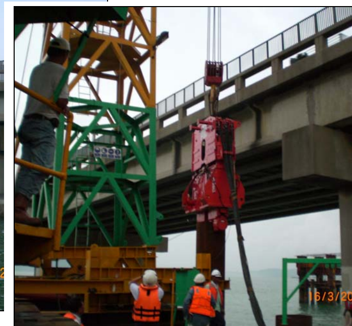
Vibmaster™ - система следит за тем, что бы уровень вибрации не превышал заданное значение
