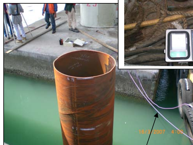
Vibmaster™ - система следит за тем, что бы уровень вибрации не превышал заданное значение
