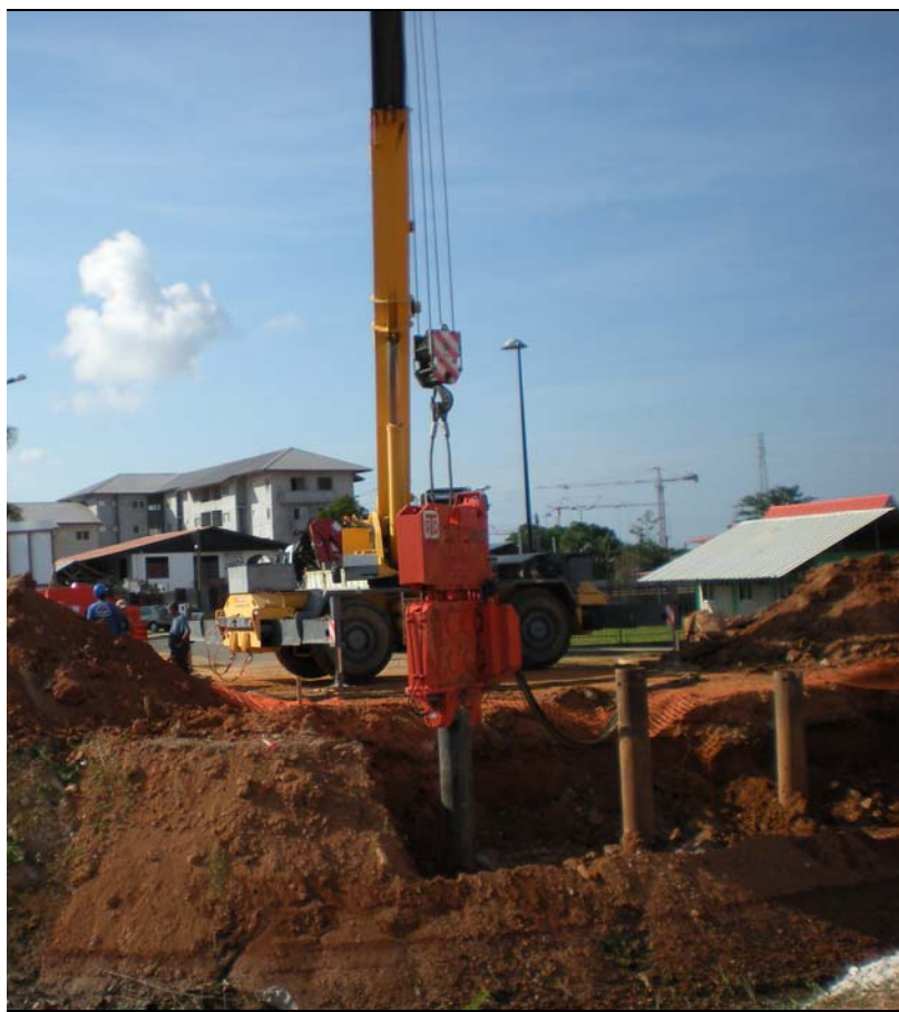
Вибропогружатель PTC 30HV на 60-ти тонном мобильном кране
